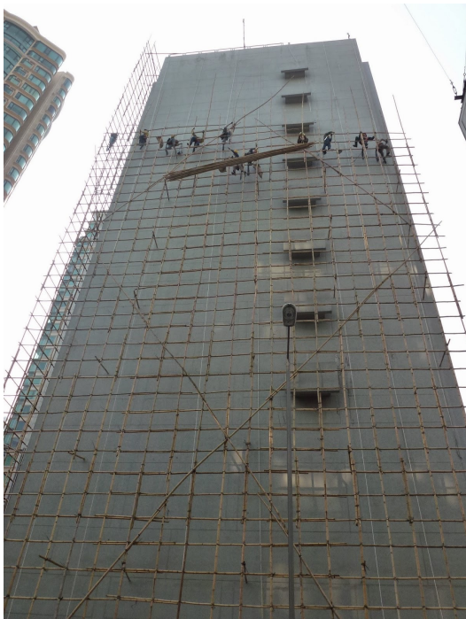
Echafaudage en bambou (Inde)
