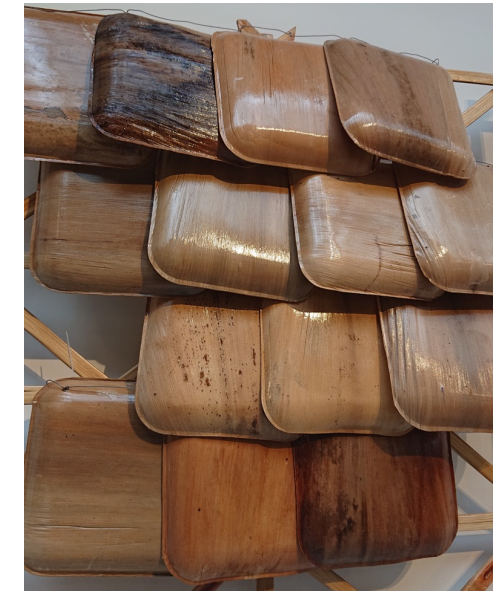
Bâtiment Cocoon, Tiruchirappalli, Inde 2014 Tuiles d'écorce de palmier moulées à chaud dans une presse mécanique et fixées par des fils métalliques. Charpente en bambou
