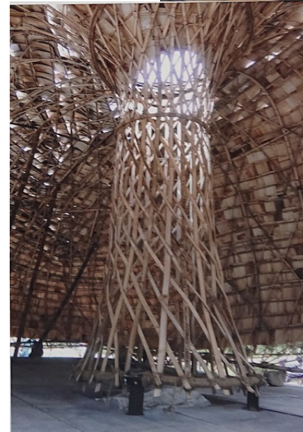
Bâtiment Cocoon, Tiruchirappalli, Inde 2014 Tuiles d'écorce de palmier moulées à chaud dans une presse mécanique et fixées par des fils métalliques. Charpente en bambou
