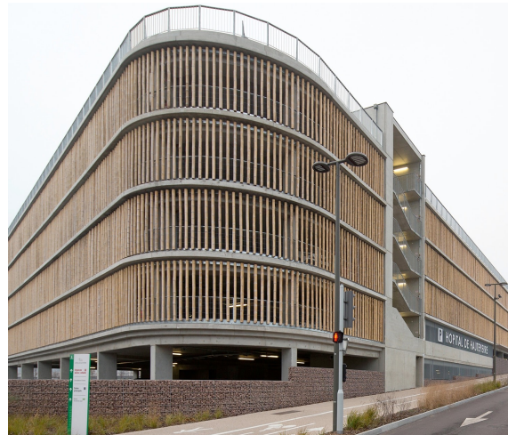
Parking du CHU de Strasbourg (bambou)
