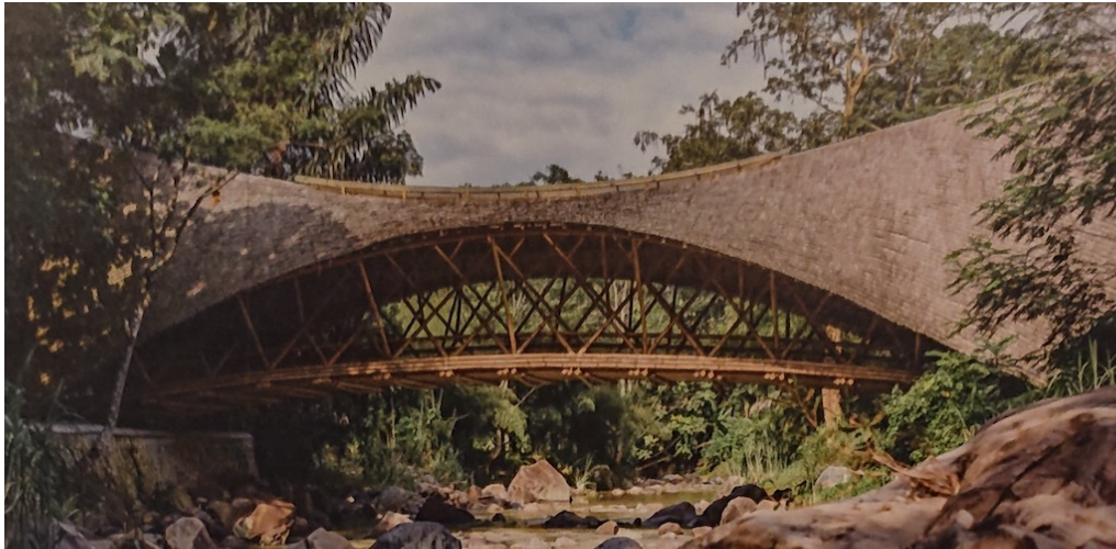
Pont routier en bambou à Sumatra, Indonésie 2017 (conception Occo Living, Zellinger, Stemm, Murrer)
